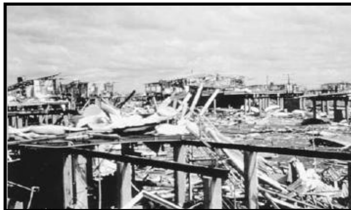
شکل ۳-۹ A - خسارات حاصل از سیکلون تریسی در داروین استرالیا، ۲۵ دسامبر ۱۹۷۴. بادهای شدید با سرعت بیش از ۲۱۷ کیلومتر در ساعت دیوارها را از زمین جدا کرده و تنها چارچوب داخلی اطراف حمام را به جای گذاشتند.
