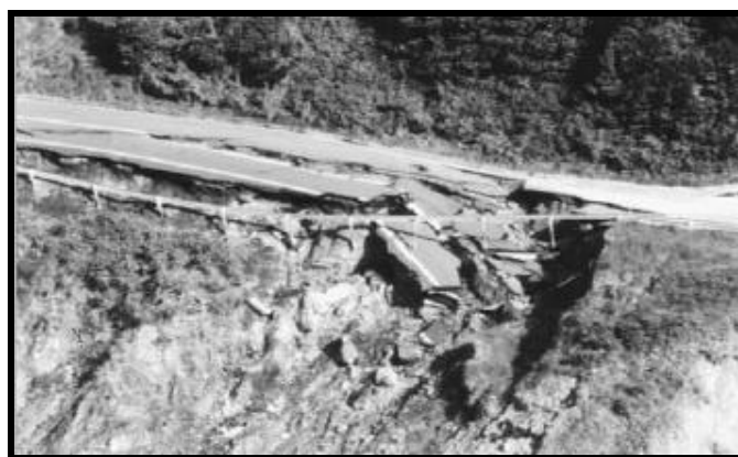
شکل ۲-۹-ب) همان رویداد بارش در شکل الف، موجب وقوع لغزش‌های متعدد و شستشوی‌های شدید که منجر به تخریب جاده و راه آهن اصلی مجاور آن شد- هزینه کلی تعمیر جاده در این مسیر ۲ کیلومتری خط ساحلی به ۱/۵ میلیون دلار استرالیا بالغ گردید. مشکلات لغزش به مدت ۱۵ سال ادامه یافت (عکس‌ها توسط باب وب، مال بیلنیویسکی و چارلز اوون، گروه جاده‌های اصلی نیو ساوت ولز، دفاتر ولن گنگ و بیلامبی).
